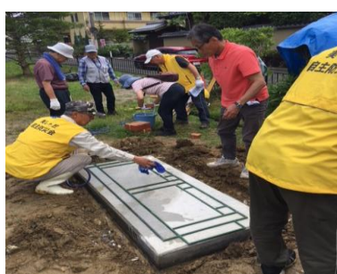
👉基礎の上に型枠を置く
