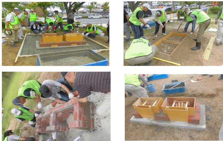
製作は、基礎セメント打ち→レンガ積み→座板製作→レンガ目地調整→金網設置→座板ペンキ塗り、といった工程で行われ、今後、第3号基設置も予定されています。ぜひ、皆さんもご覧になって、腰をかけてみてください。
