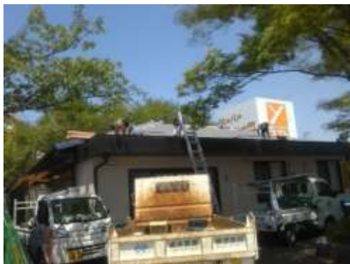
集会所屋根工事の様子
